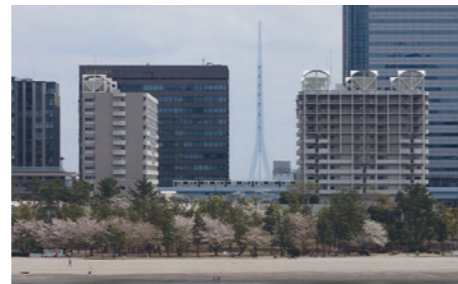
第三台場から見たテレポートブリッジ。右側のお台場海浜公園駅へ向かうゆりかもめが通過
